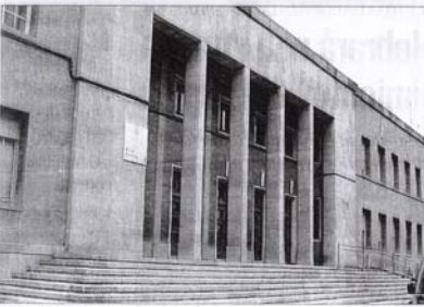
La falta de espacio es uno de los problemas más acusados de la Escuela de Enfermería
